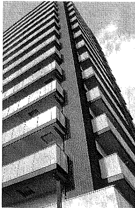
フラットレールを施工したマンション
